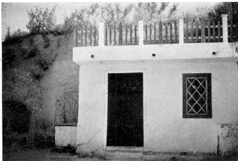
22. kép. Az utolsó solymári löszlakás. A régi lakás elé téglából új szobát építettek már.
